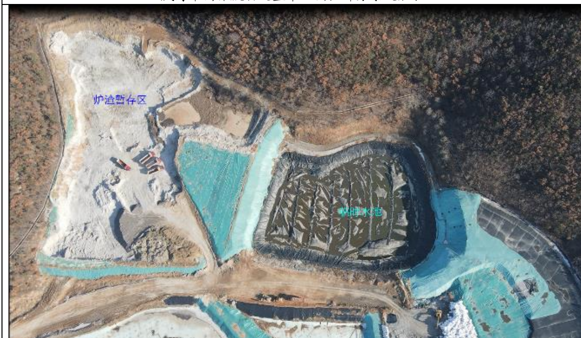
拟建项目场区航拍
