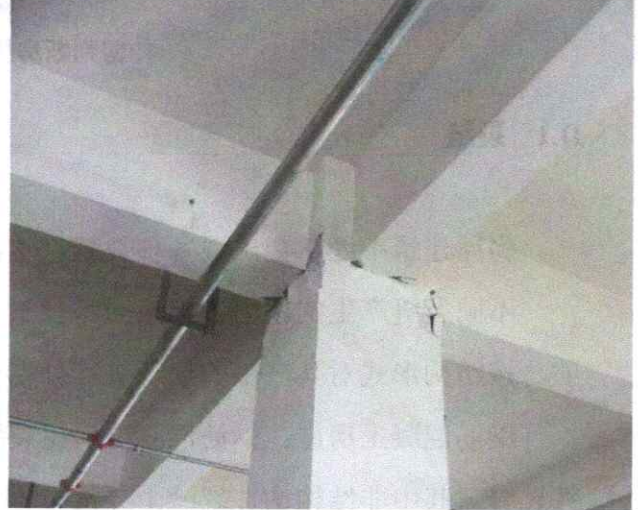
混凝土结构构件裂缝
