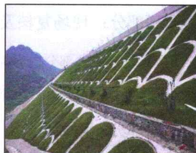
图-圬工加植物防护
