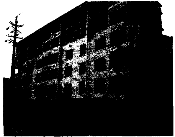
底部框架-抗震墙结构
