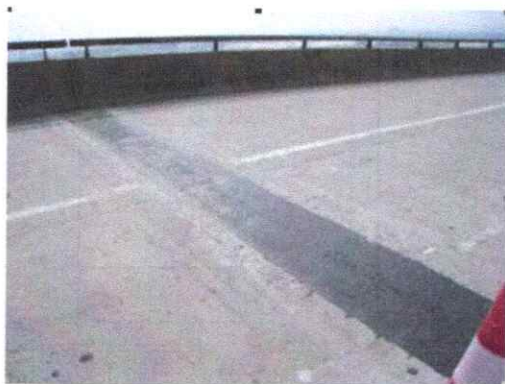
无缝式伸缩缝
