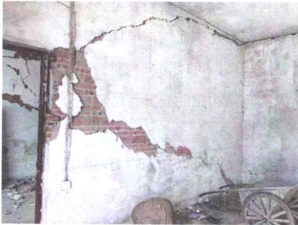
砌体结构构件裂缝
