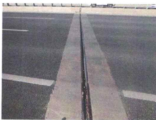
异型钢单缝式伸缩缝
